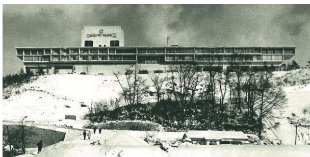
<開業当時の外観>
